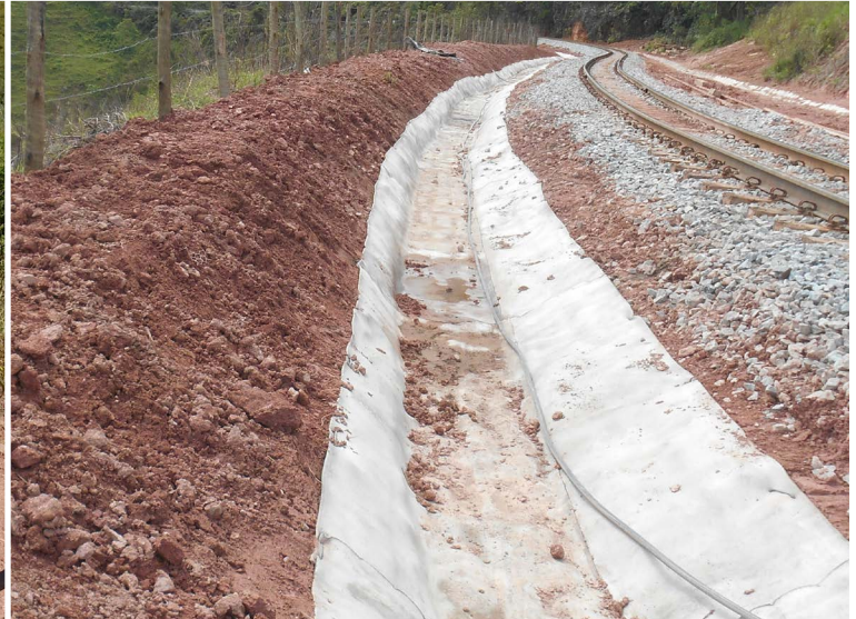
CC laid longitudinally
